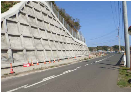
図9 拡幅工事後のコンクリートのり面
